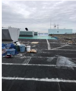
下地ゴムシート撤去
