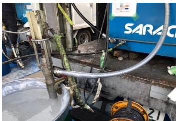
現在ホース交換済施工順調
