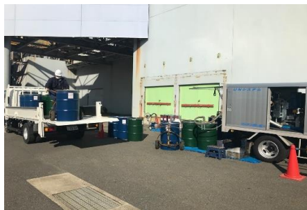
材料は2トングート車で都度運び込み現場 初回材料EZを10セット搬入
