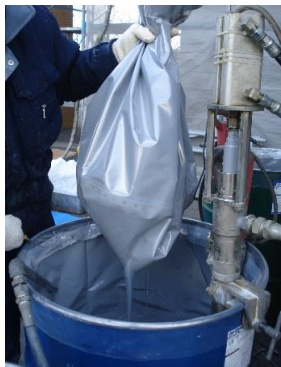
カッターで切り材料を移し変える (材料にムダ無し)
