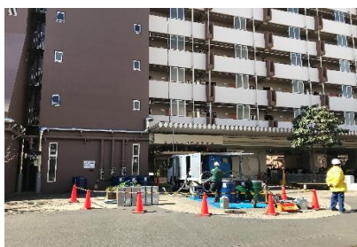
カラーコーンで広い作業スペース確保
