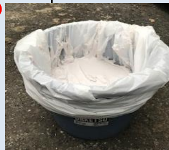
廃液をビニールまたはポリバケツ等で硬化させ、 廃プラゴミ として処理へ
