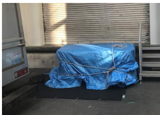
A: 1層目施工後ドラム缶を養生
