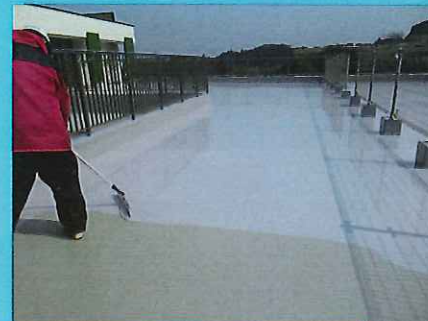
ハンドレーキによる施工
