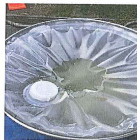
ドラム缶雨水進入(拭き取り施工へ)
