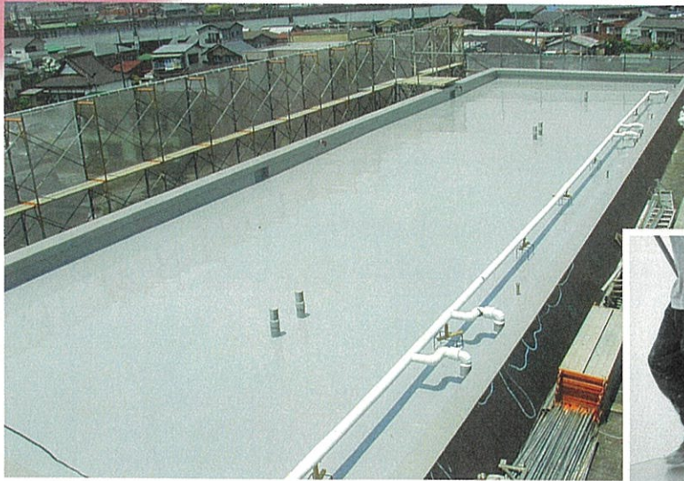
■ 屋上防水工事
