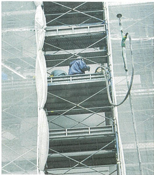
▲ ベランダ施工
