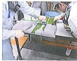
実施工の確認
