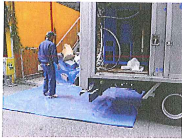
AM8:30現場着 施工準備開始 UN車後方作業スペース準備
