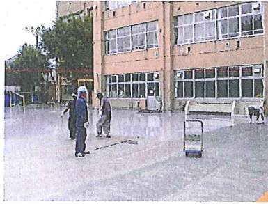
台車で運び素早く施工
