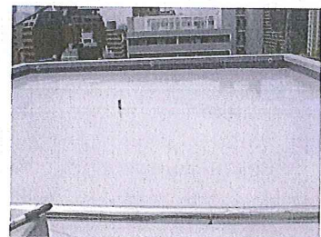
AM11:30 施工完了 (600㎡)90分にて施工終了
