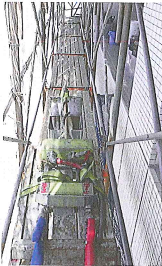
狭い足場でもラクラク先端操作部設置 青:硬化剤 赤:主剤
