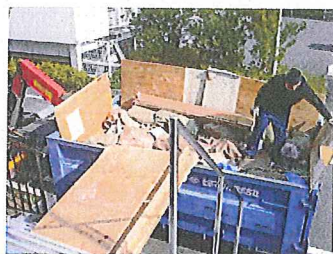
階段はコンパネを利用し積込ます
