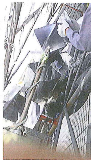
一斗缶で完成したウレタン をラクラク受ける
