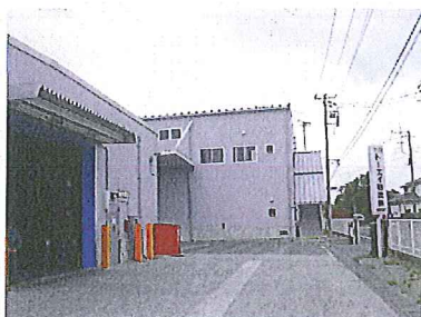
1200坪の敷地に危険物倉庫200坪×2棟 一般倉庫430坪の堂々たる配送センター
