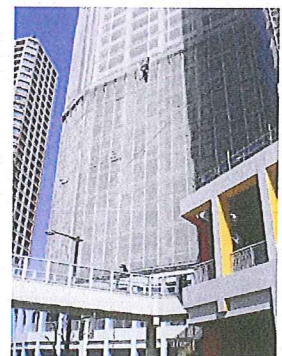
(高層マンションUNウインチ使用中)
