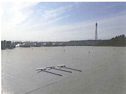
施工初日の屋上1500㎡
