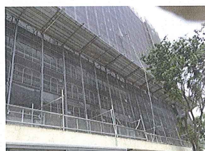
施工するベランダ面
