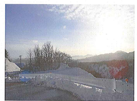
最終処分場グリーンフィル小坂270万㎡ この大自然の右に深く掘られた最終埋立地あり
