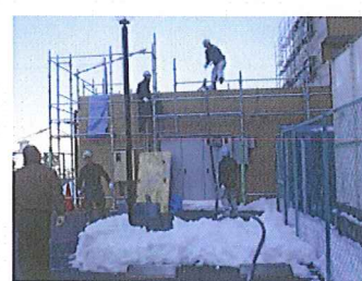
50m先の80㎡の屋上へ先端部移動
