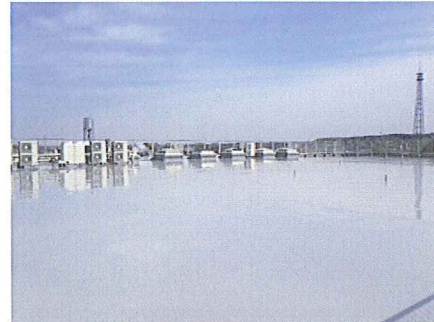
一層目終了後の屋上
