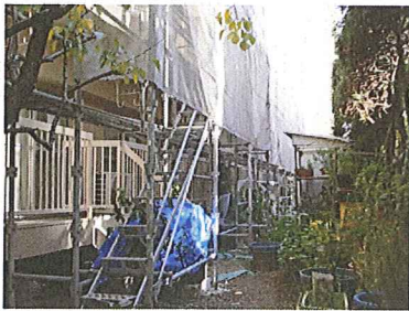
物件裏 屋上へ上がる架設足場
