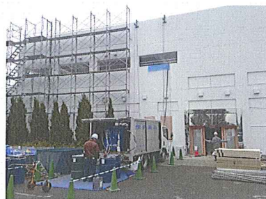
2階駐車場を施工
