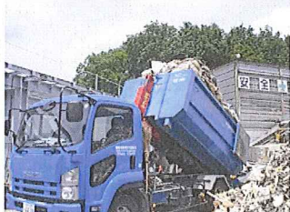
⑦処分場で ダンボール・廃プラを分別後 混廃捨場へ
