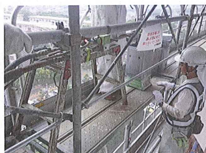
足場に先端操作器設置 攪拌済のウレタン吐出
