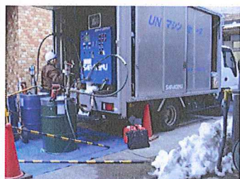
雪が残る現場
