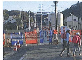
未だ海岸方面では立入禁止の看板
