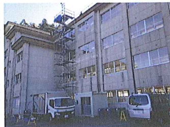
裏側にUN車止め施工
