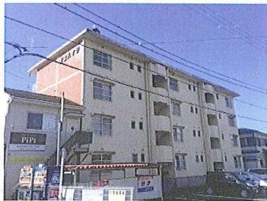
物件外観 4階建てハイツ 屋上250㎡ 内部階段でハッチを開けて屋上へ
