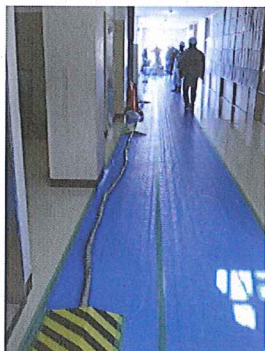
目一杯ホース伸ばし 第一施工場所へ
