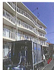
架設やぐらでホース上げ
