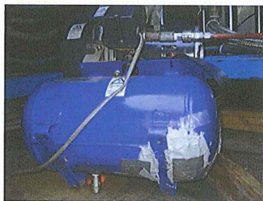
タンク底に劣化穴発生 クイックメンダーで補修
