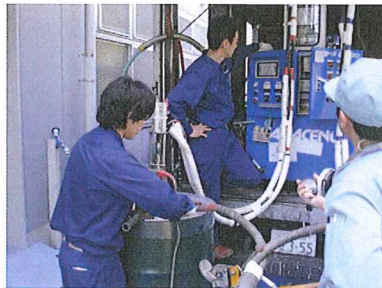
CP設定後の流量試験(主剤・硬化剤) ストップウォッチで流量検査
