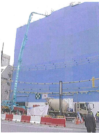
コンクリートポンプ工法
