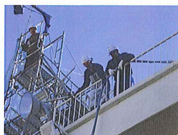
照明を避けウインチでホース引上げ後 ホースを手で手繰り寄せ
