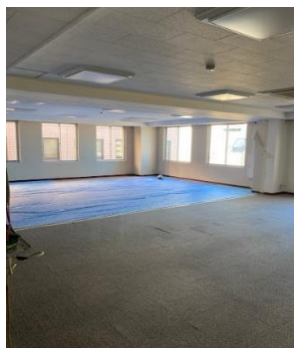
現状復旧中の事務所
