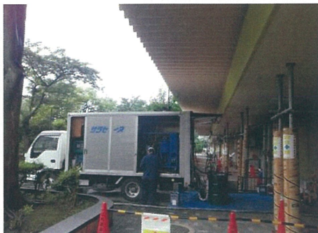
大庇を利用して材料を雨から守る
