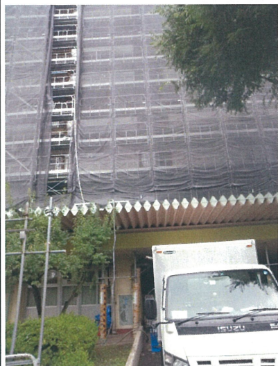
圧送ホースを底上を這わしてウインチでつり上げ つり上げ時にホース伸ばしのノウハウが必要
