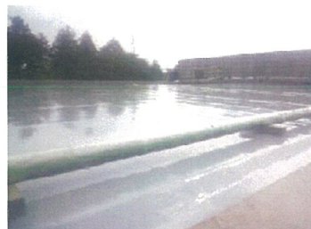
2層目サラセーヌAを施工
