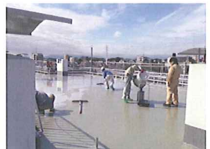
慣れた手付きで素早く施工
