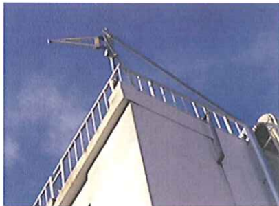
やぐらはウインチを取付そのホースを手繰る時に取り出ししやすい様に高さを考えて組みます
