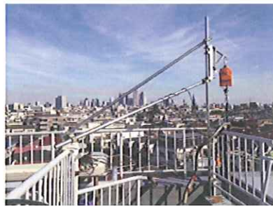
やぐらはウインチを取付そのホースを手繰る時に取り出ししやすい様に高さを考えて組みます
