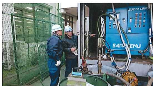
UN現場施工初体験
