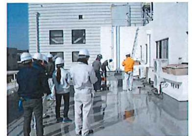
屋上で実際の施工の様子
