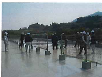
施工状況見学
