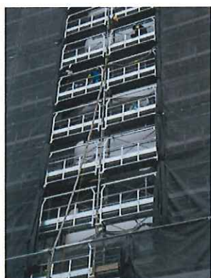
ベランダの施工
