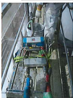
足場に先端操作機
