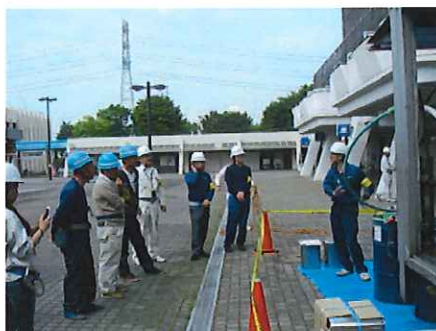
石川OPのUN施工要領説明
