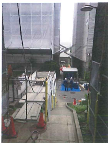
ベランダの現場
