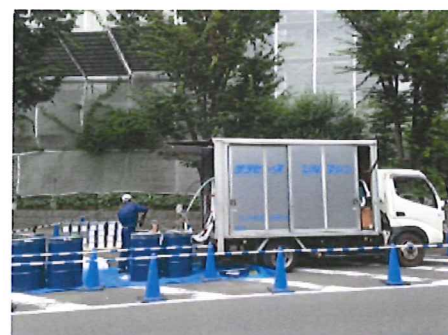
900㎡の屋上を施工
