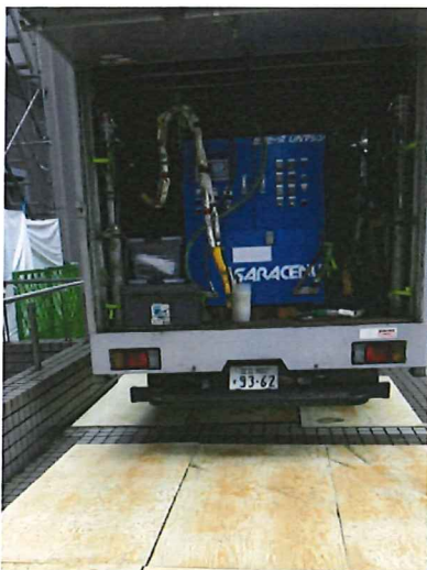
もちろん汚さず施工
