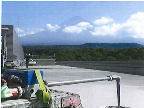
富士に見守られて施工
