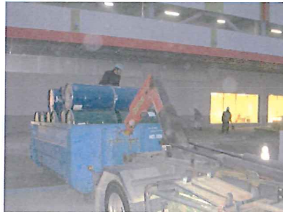
コンテナを下ろす
