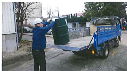
産廃2トン車でドラム空回収
