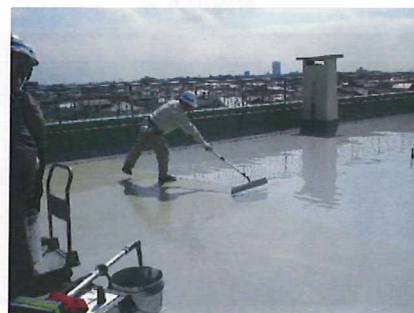
ラクラク施工の屋上
