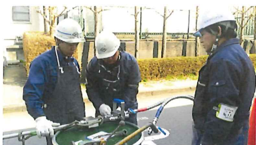
先端操作部に慎重にホース取り付け
