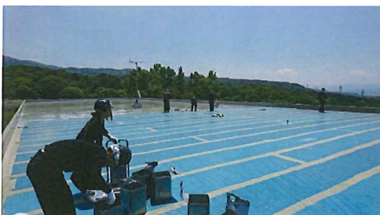
晴天での施工
