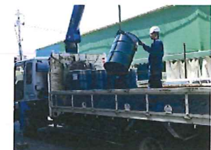
ユニック車でドラム降ろし
