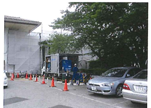
事務所をUN施工
