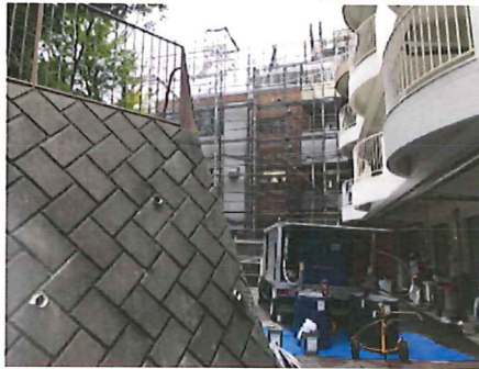
5号機でのベスト施工ポジション
