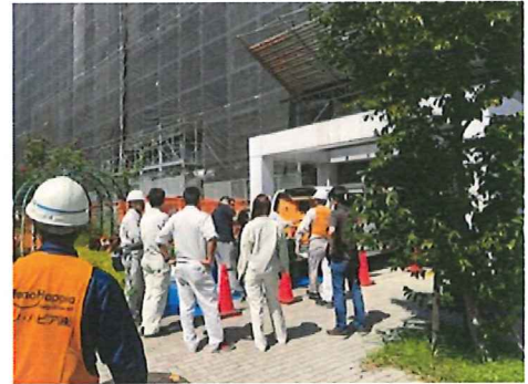
楽マシーンでのベランダ施工
