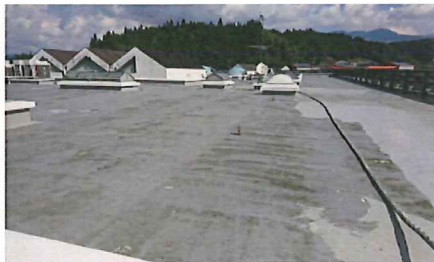
屋上風景: Befor(前)
