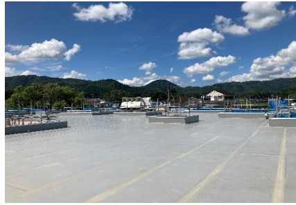
都合2,500㎡の高齢者施設屋上
