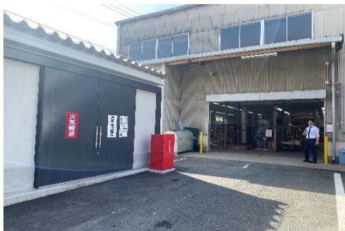
危険物倉庫と一般倉庫
