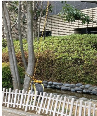
通路及び安全ネットの邪魔にならないように木にロープを付けてウインチ上げ下げ
