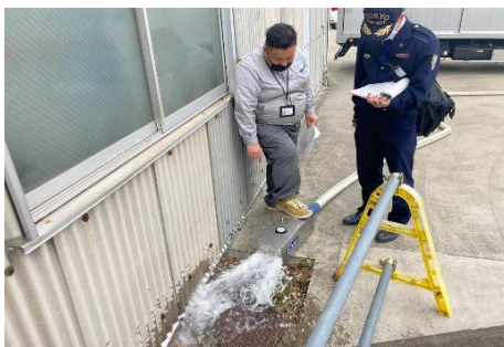
消火設備点検
