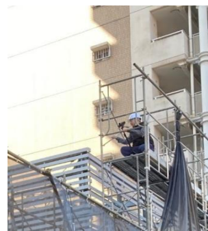
動画で現場施工確認中
