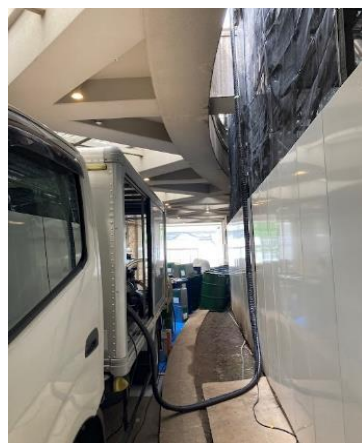
エントランス通路先にマシン設置
