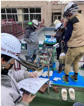
先端操作部屋上設置
