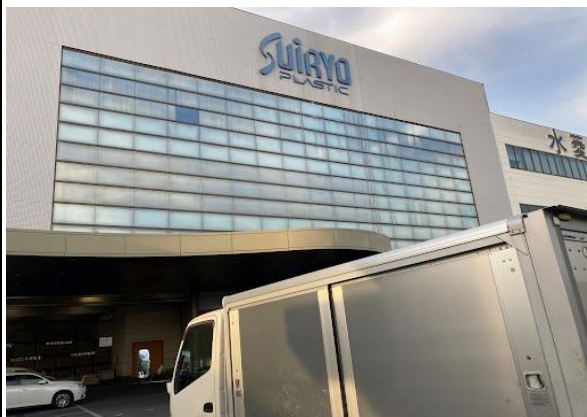
岡山県倉敷市の自動車内外装プラスチック部品専門メーカー 水菱プラスチック株式会社(1,500㎡)
