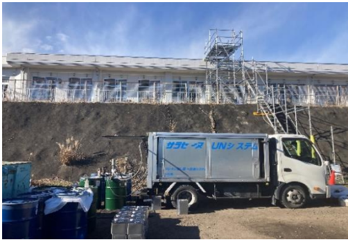
UNマシン5号機設置
