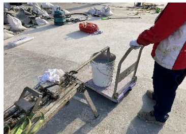
既存下地剥がした奥からUN施工
