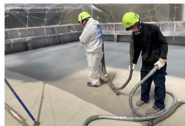
リムスプレー施工
