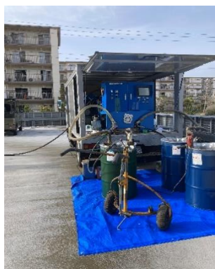
2階駐車場にUN設置
