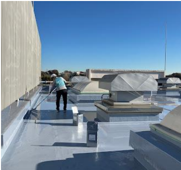
レーキでラクラク施工
