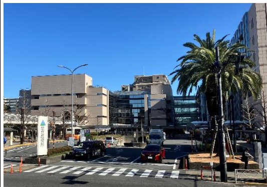
堂々とした北・中央・南館がある足立区役所
