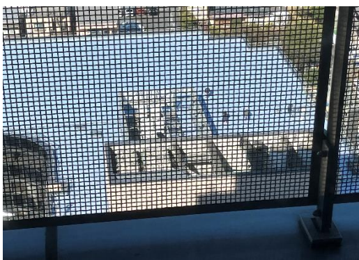
南館屋上より北館(屋上施工中)
