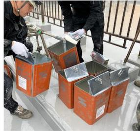
UN先端操作部よりの攪拌済ウレタンは1分間に10リットル吐出が平均UN施工となっており一斗缶に約10リットル強程入れて運びますが、6缶乗る台車で移動しその間空缶6缶にウレタンを吐出していきます。時間は約10分で
