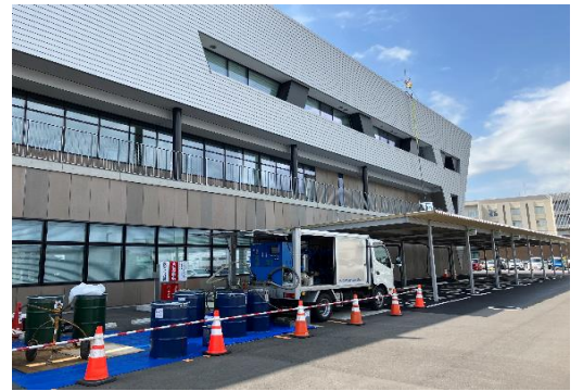
⇒ AM9:00着福岡県鞍手郡の鞍手庁舎1,800㎡施工
