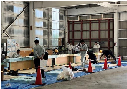
第二倉庫手前から15M会場使用
