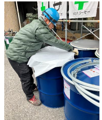
2層目に備え残材料養生し保管
