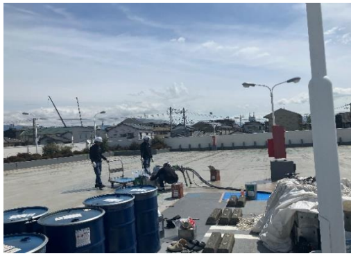
沼津市のコジマ電気屋上駐車場都合3,200㎡の内 急ぎA工区1,600㎡のAD-H30工法のUN施工
