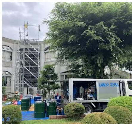
木陰で涼しくUN車設置
