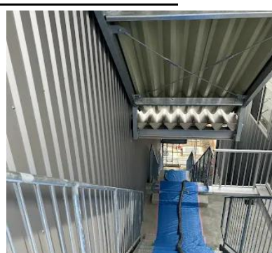
新築のやまみ富士山麓工場は階段部分を養生しホースを這わして2階部分の床をサラサーヌEZで施工
