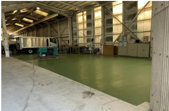
第二倉庫入口右側すべてに床材塗布完成＼(^o^)／
