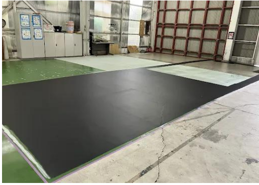
新商品帯電防止の床材の試験施工中
