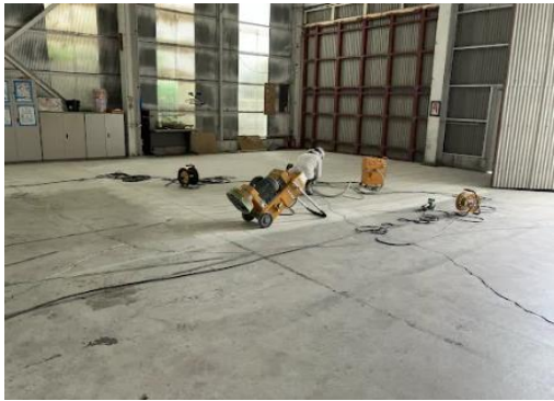
下地つくり、クラック部Uカット
