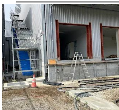
新築のやまみ富士山麓工場は階段部分を養生しホースを這わして2階部分の床をサラサーヌEZで施工
