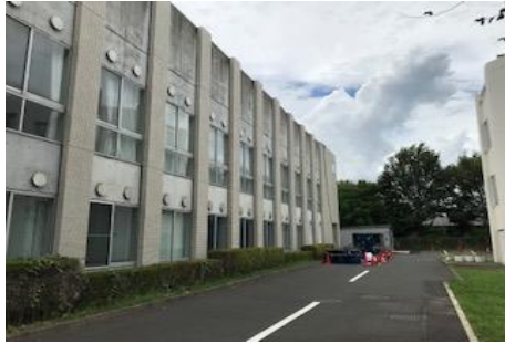
江戸川大学N棟施工
