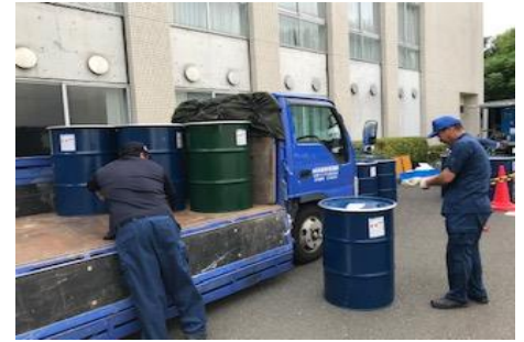
施工後産廃Dが空ドラムすばやく回収
