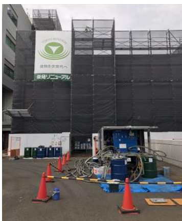
東急建設技術研究所現場
